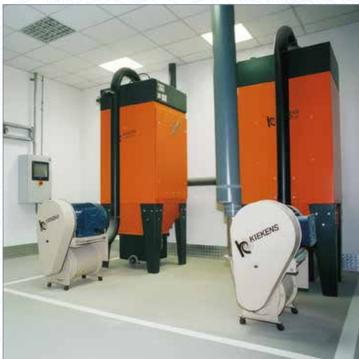
Sistema de aspiración centralizada con unidades Dustmaster y turbinas Kiekens.
